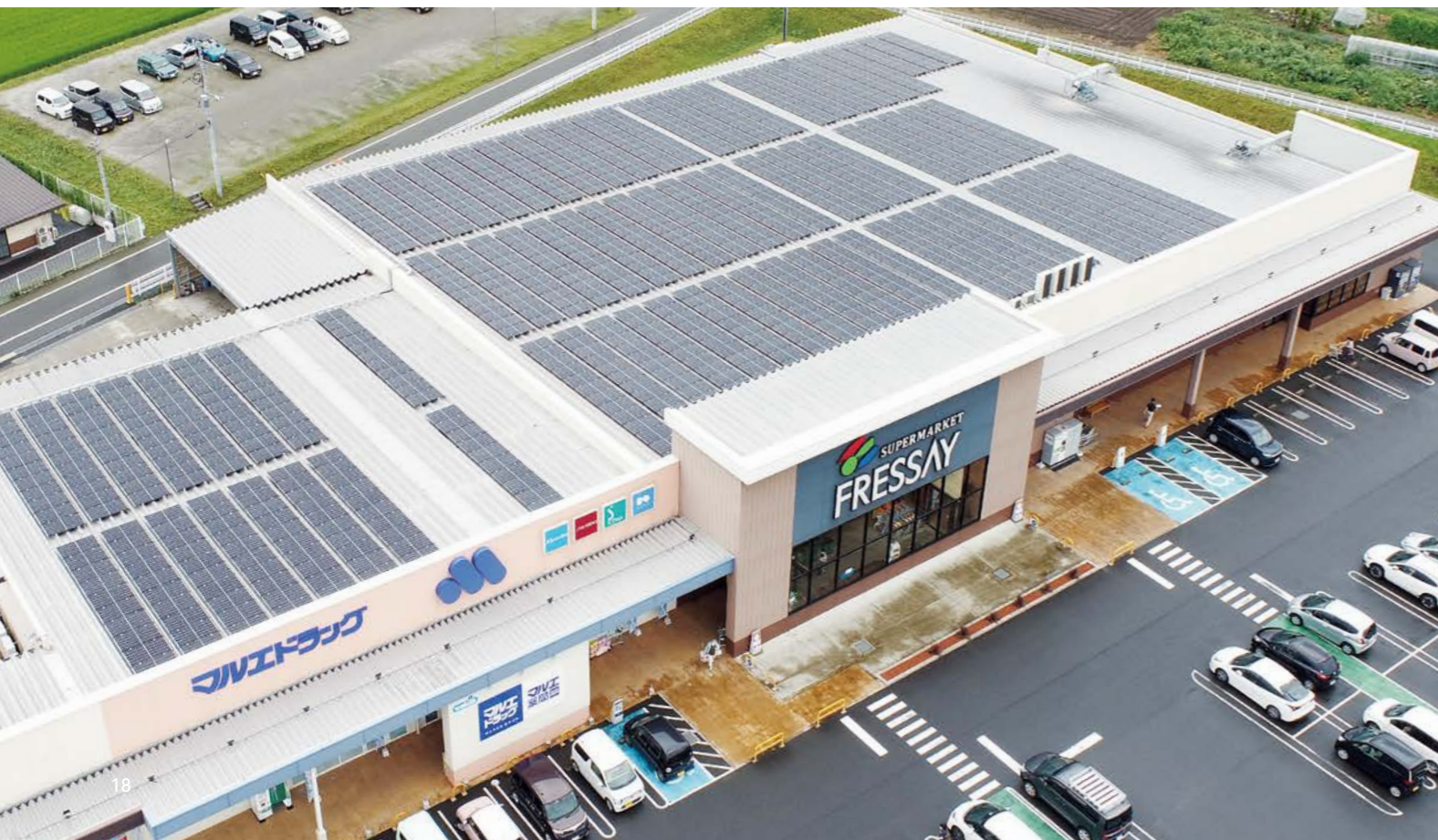
「オフグリッド電力供給サービス」の太陽光発電システムを、スーパーマーケットの屋根に導入した事例。写真はフレッシュイイ棟東新井店。
