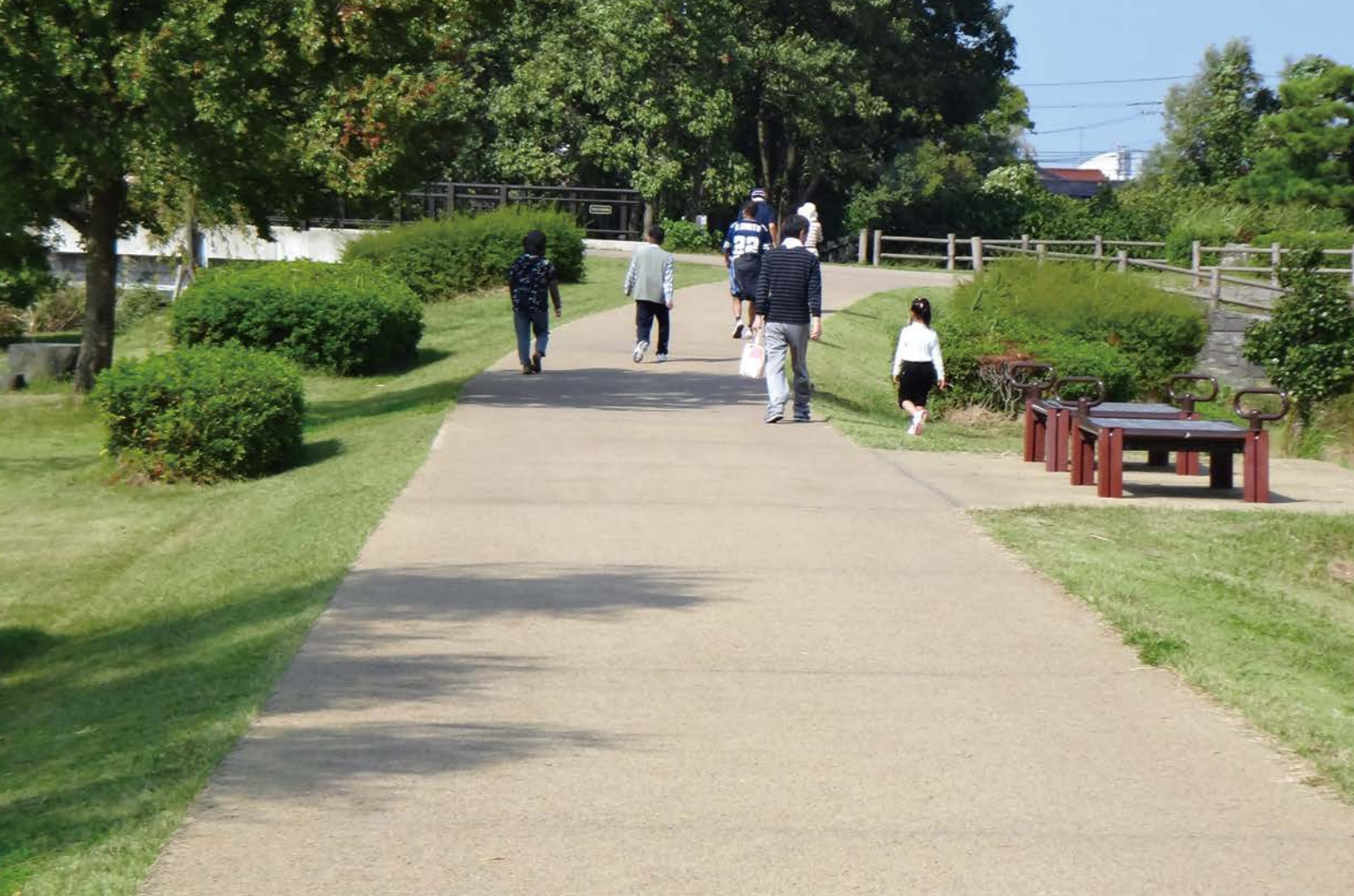
石川県小松市にある木場湯公園の周遊園路は、すべてエコシステムの瓦舗装材を使用している。ソフトな歩行感が特徴だ。
